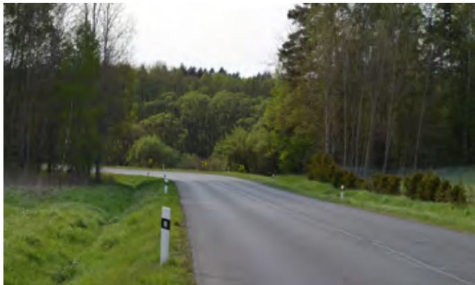
Další příklad nehodového směrového oblouku s menším poloměrem, navíc bez VDZ a s vodním zdrojem v blízkosti (častější výskyt vlhkého povrchu vozovky)
