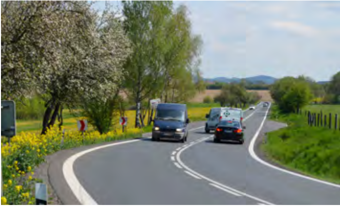
Příklad nebezpečné křižovatky umístěné za málo přehledným směrovým obloukem (odbočení je těsně za modrým OA vlevo)
