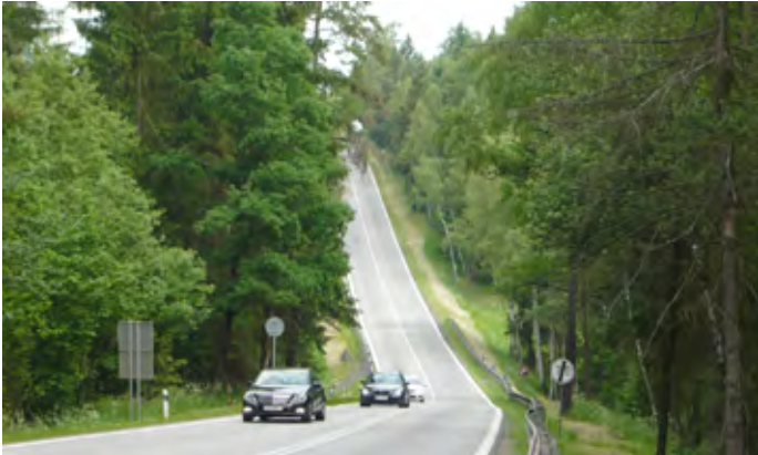
Příklad údolnicového oblouku s malým poloměrem, kde se v nejnižším místě oblouku značně zkracuje dosvit světlometů
