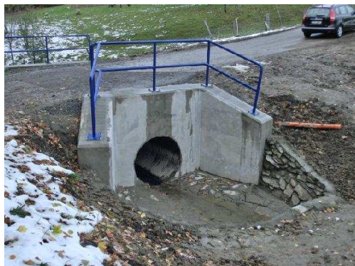
Obr. 1 a 2 Propustek před a po ukončení rekonstrukce
